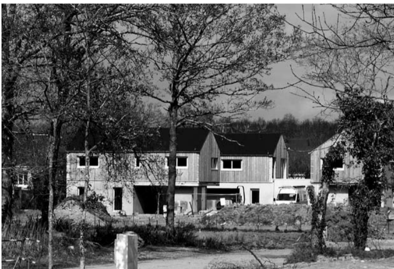
Chantier du Clos du Moulin à La Chapelle-des-Marais
